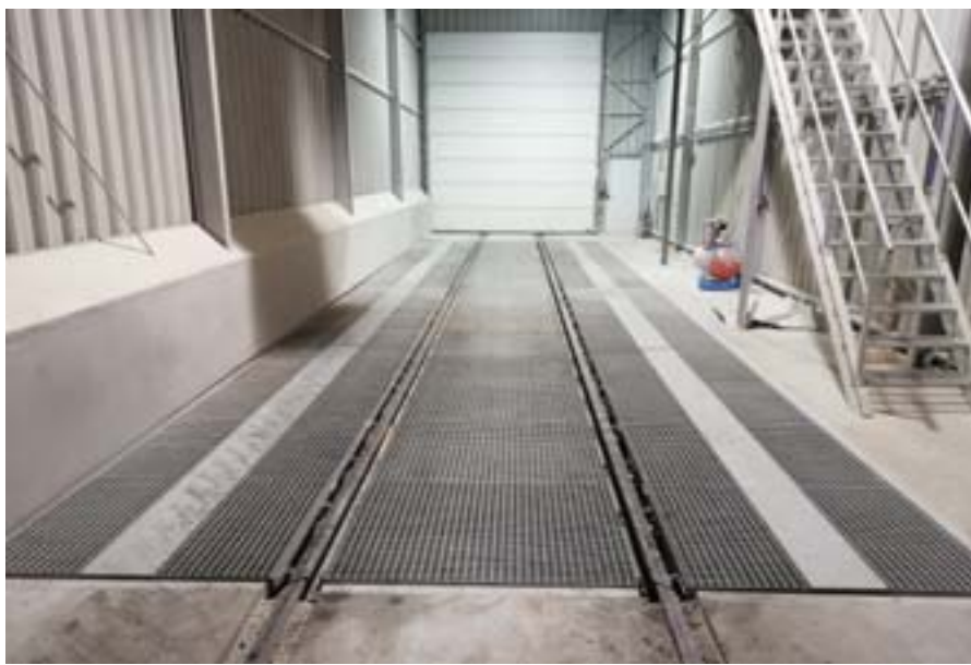
FOT. 1 Waga kolejowa na koszu rozładunkowym [źródło: Automatyka Serwis]
